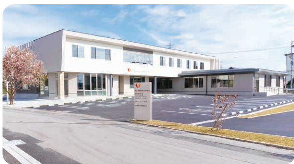
新築移転した虹・本部棟
