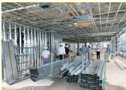
2階にはたくさんの鉄骨が運び込まれています
